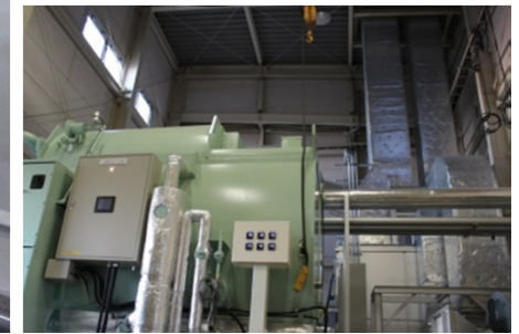
排熱で湯を沸かし、湯を動力源に利用
