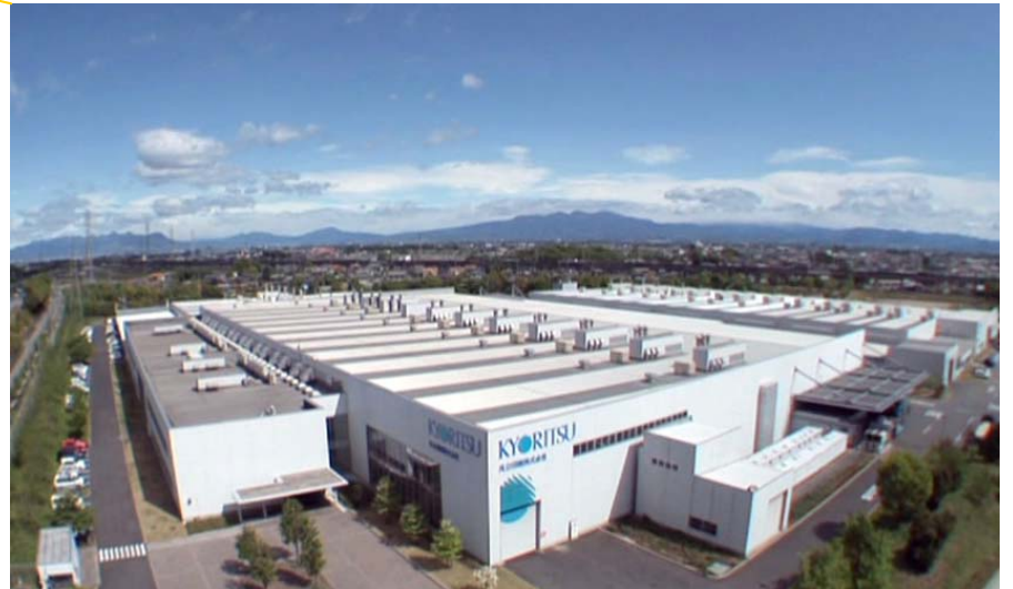
1999年に完成した、大規模集約型の印刷工場
