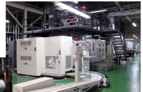
2013/7、2013/11 A判輪転機を増設
