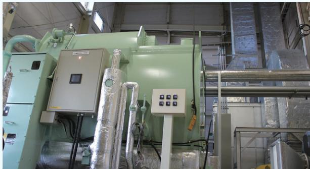
本庄第1工場で稼動する「廃熱回収式吸着冷凍機」
