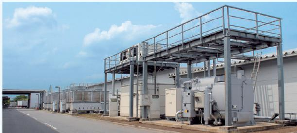
本庄第2工場に増設した新しい「廃熱回収式吸着冷凍機」
